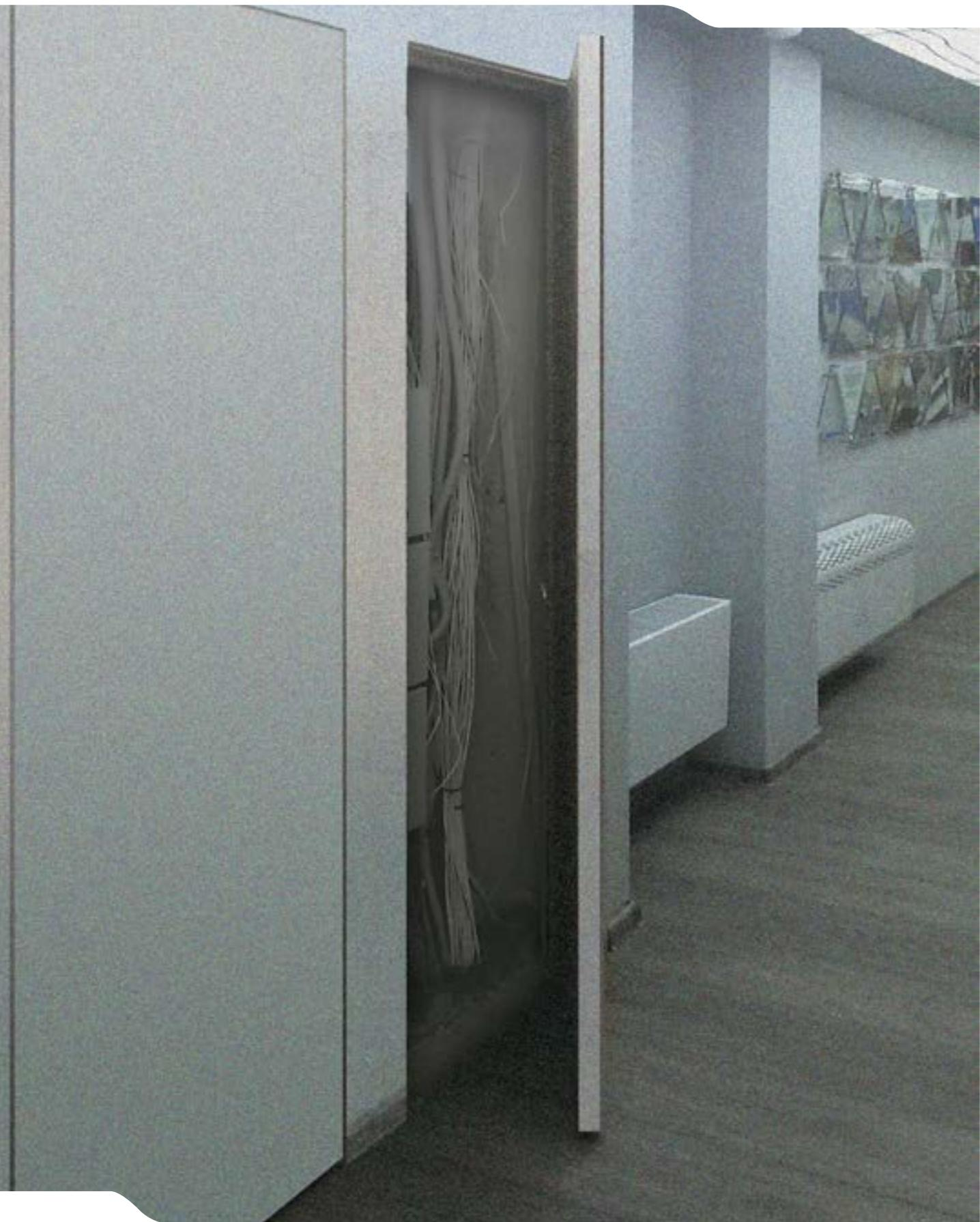
Ревизионный люк-дверь MAXIDOOR предназначен для установки в стены, выполненные с применением любых строительных материалов, и служит для обеспечения быстрого, беспрепятственного доступа к инженерным коммуникациям, проложенным в стенах – как правило, к межэтажным шкафам электро-коммуникаций и шахтам сквозного водоснабжения. Люк-дверь Maxidoor выпускается в двух вариантах исполнения:
